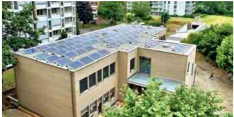
Kindergarten Steinfeld: PV-Anlage mit Volleinspeisung
